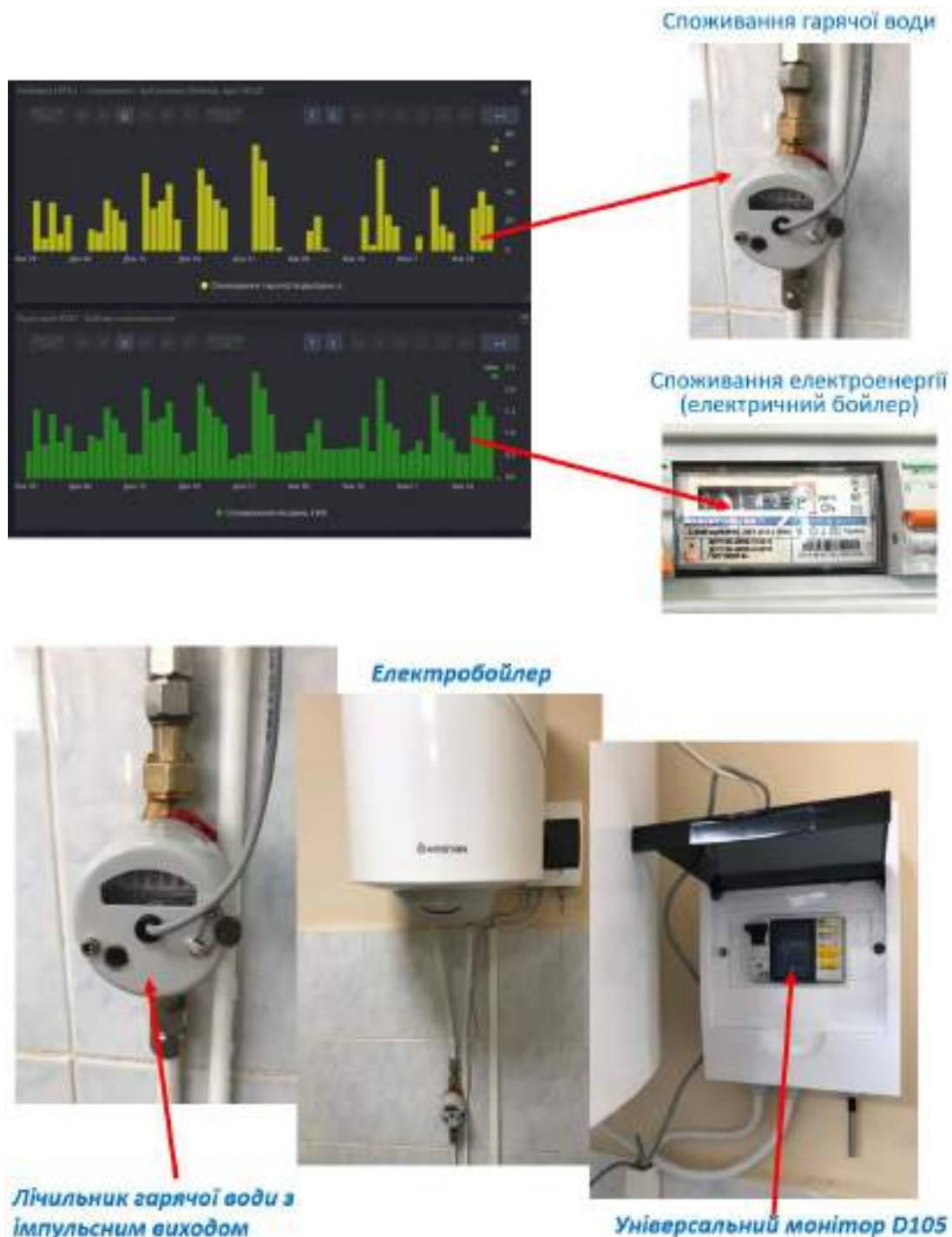
Рисунок 7 – Приклад реалізації моніторингу споживання гарячої води в будівлі і витрати електричної енергії на її приготування
