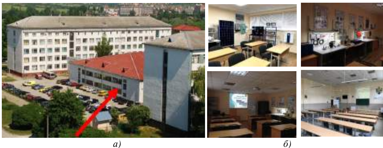
Рисунок 2 – Навчальний корпус №9 ІФНТУНГ (а) та аудиторії кафедри «Енергетичного менеджменту і технічної діагностики» (б)
