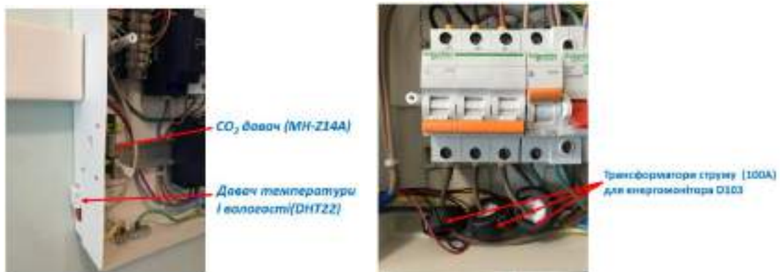
Рисунок 4 – Приклад інсталяції сегменту системи енергетичного моніторингу для навчальної аудиторії університету
