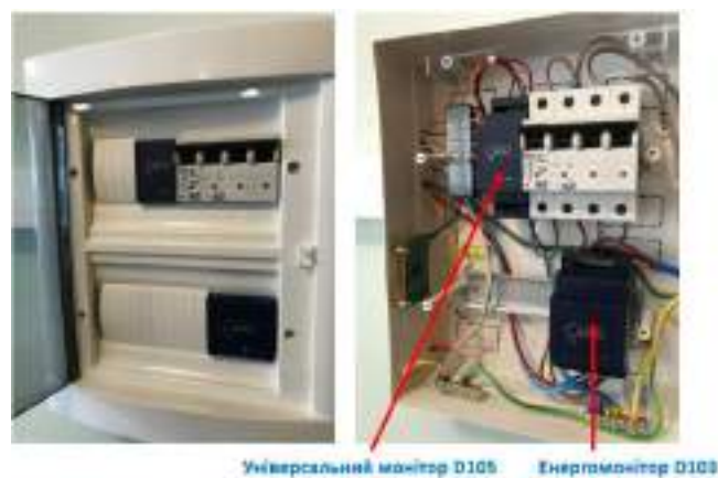
Рисунок 3 – Загальна структура пілотної системи енергетичного моніторингу для навчальної будівлі університету
